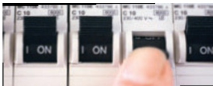
Automatsäkringar = dvärgbrytare
