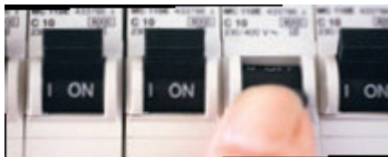
Automatsäkringar = dvärgbrytare
